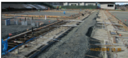
Gymnasium Conduits and Drain Rock
